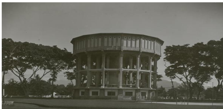
Fig. 4. Watertoren building in Gemeente Magelang
